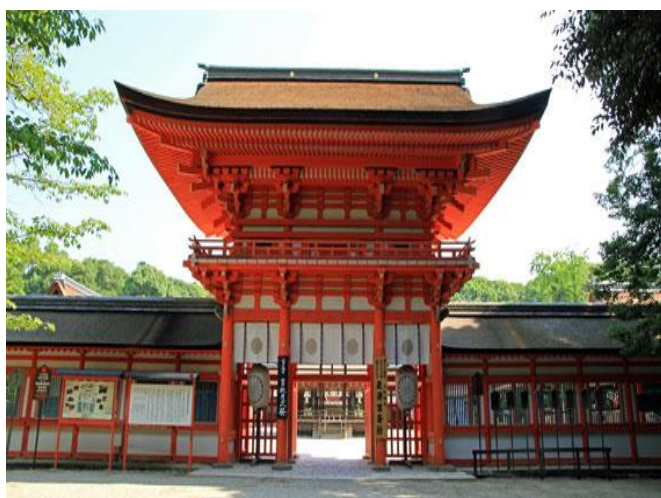
賀茂御祖神社（下鴨神社） 楼門
