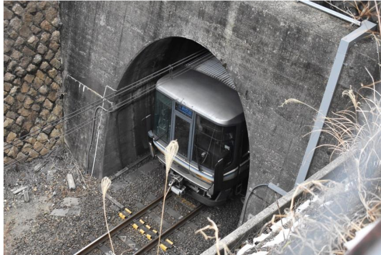
弾丸列車規格で建設された 東山トンネル 下り内側線 西口
