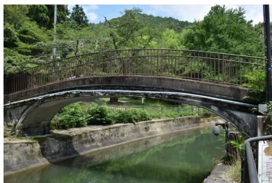
日ノ岡第 10 号橋
