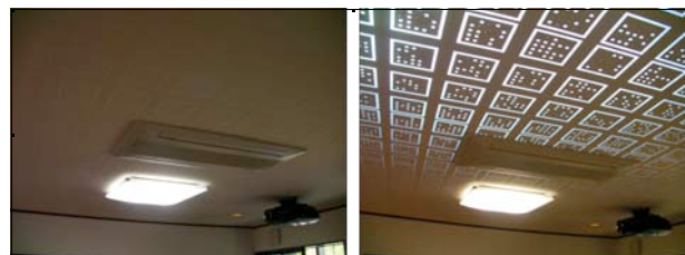
(a) 不可視マーク (フラッシュなし撮影) (a) Invisible Markers without a Flash (b) 不可視マーク (フラッシュあり撮影) (b) Invisible Markers with a Flash
